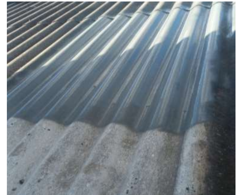
TELHADO APÓS LIMPEZA E PINTURA EMBORRACHADA
