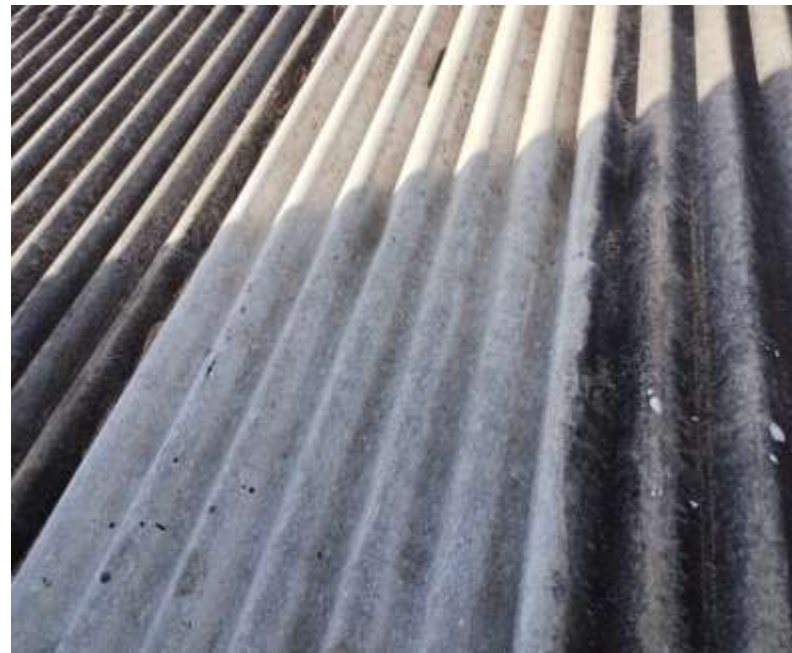
TELHADO APÓS LIMPEZA
