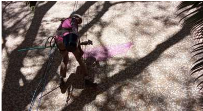
FAIXA TESTE EM EXECUÇÃO DE LIMPEZA
