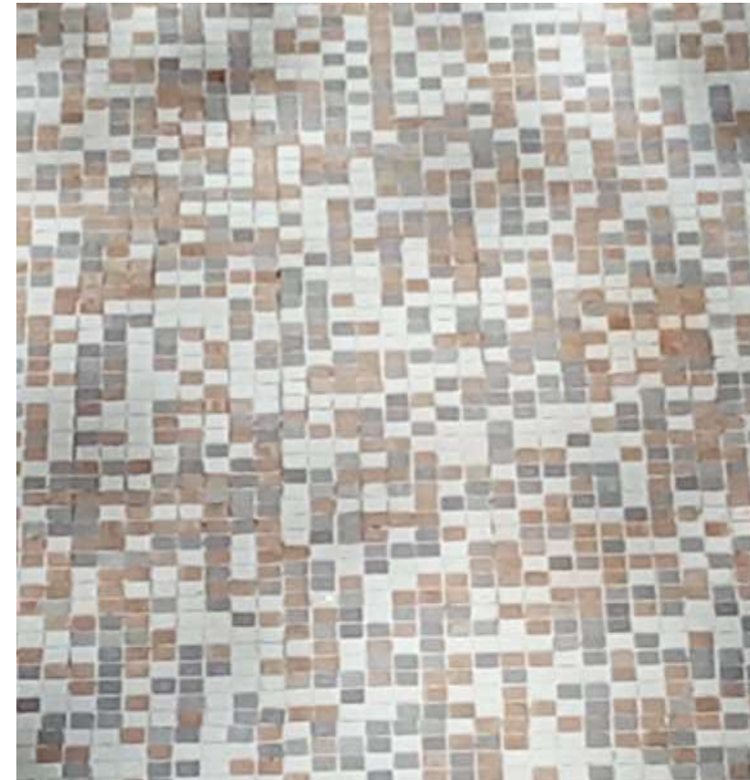
FAIXA TESTE - LIMPEZA EXECUTADA
